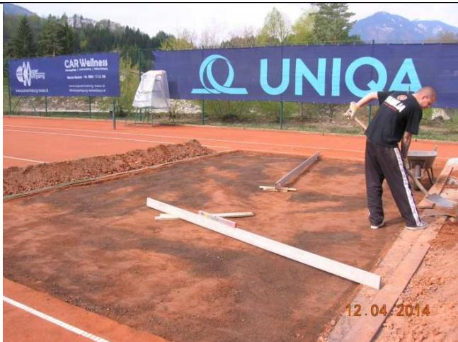
Platzwart Peter (nur kurzfristig im Frühjahr 2014) zum Zeitpunkt des fertigen sorgfältigen Abhubs der Deckschicht von der darunterliegenden Dynamischen Schicht.
