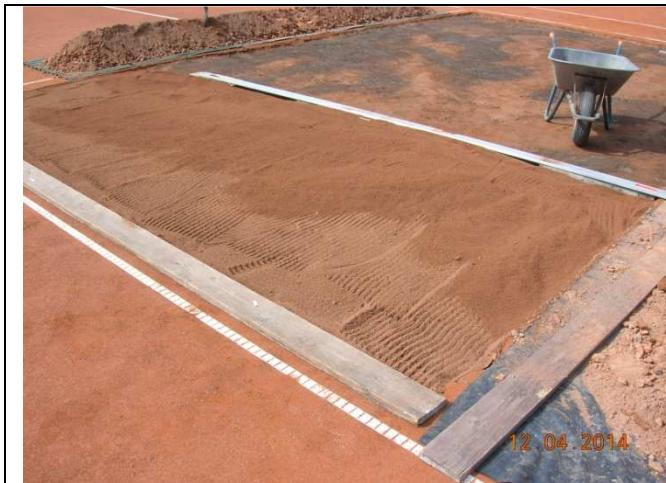
Beginn des Eintragens des durch Absieben regenerierten Deckbelags, der direkt neben der Arbeitsstelle zwischengelagert und dort mit dem im nächsten Bild sichtbaren Hochsieb abgesiebt worden ist.
