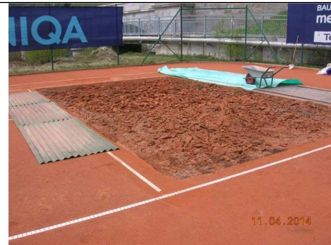
Die Deckschicht wurde vor dem Wegschaufeln auf eine Unterlage zuerst einmal mit der Spitzschaufel sorgfältig von der Dynamischen Schicht getrennt.
