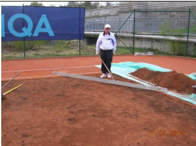
Der „Gehilfe“ Wilfried Fasching bei der Abschaufelung des vorgelockerten Deckschichtmaterials auf die Unterlagen.
