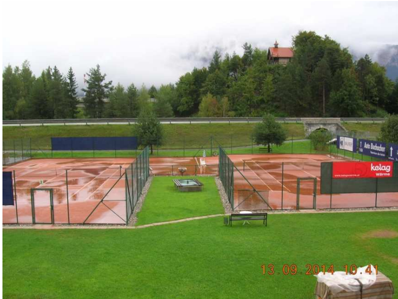
Bild TPS B-01: Wasserlachen nach Starkregen als Nachweis für die Unebenheiten auf den Plätzen 1 und 2.
